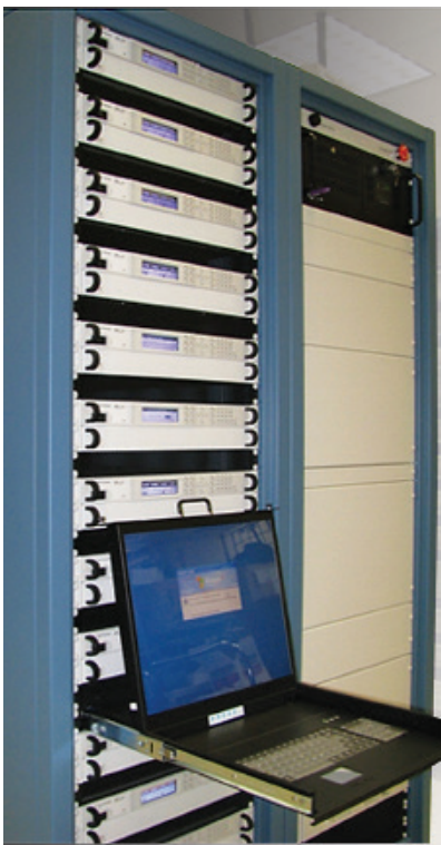
Рис. 12. В левой стойке размещены 12 приборов серии Keysight E4360A, которые обеспечивают 24 канала имитации солнечных батарей.
