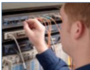
Вставьте тампон в порт и несколько раз поверните его с легким нажимом. Замените слегка смоченный тампон сухим и воспользуйтесь этой же процедурой для удаления остатков растворителя с торцевой поверхности или оплетки.
